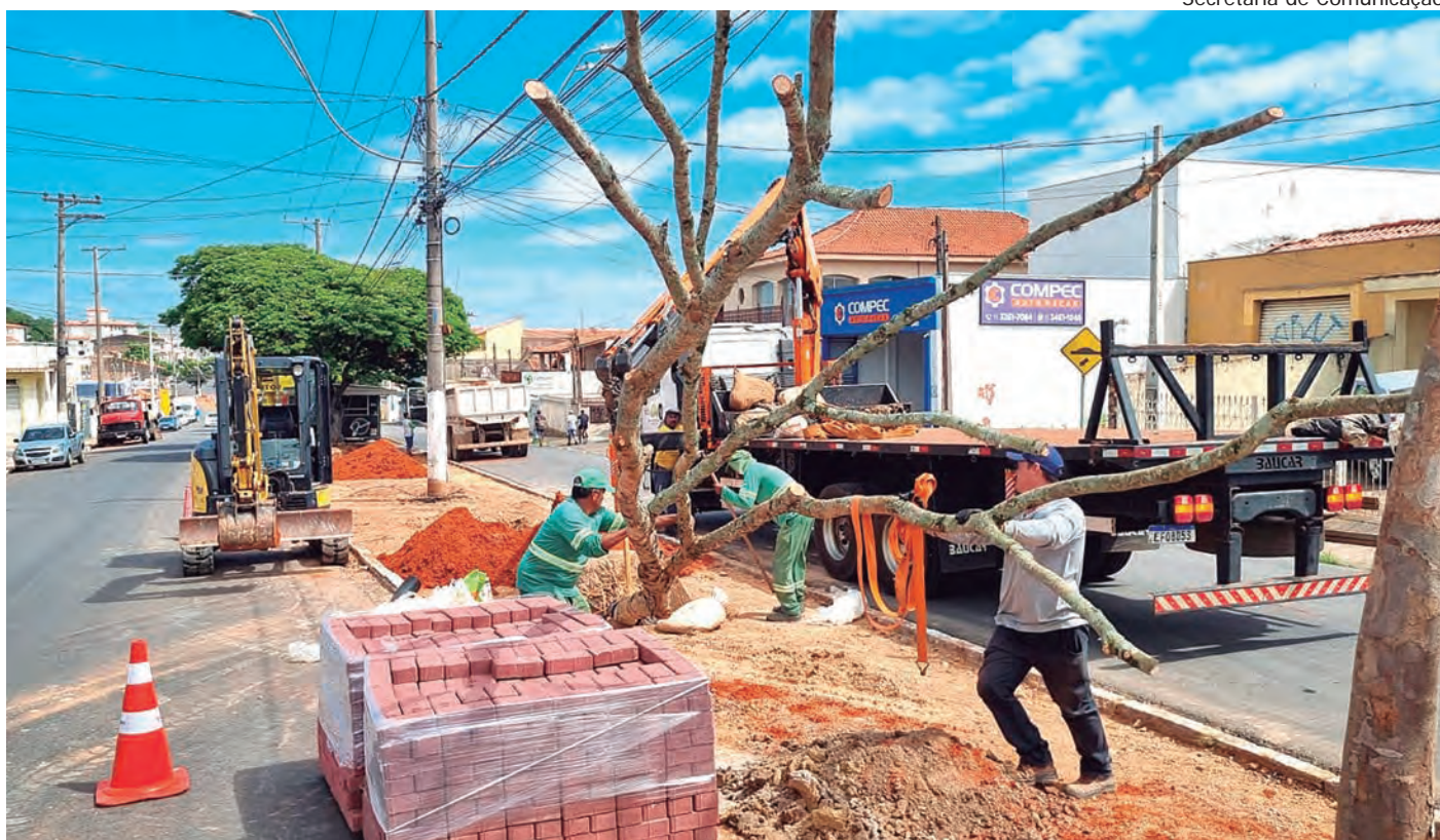
AVENIDA DE CARA NOVA. Prosseguiram nesta semana as obras de revitalização do canteiro central da avenida Armando de Salles Oliveira (Vila Progresso). A equipe da Secretaria de Serviços Públicos continuou retirando os canteiros antigos e nivelou o solo. O canteiro está recebendo pisos intertravados. A Secretaria também deu início ao plantio de árvores.
